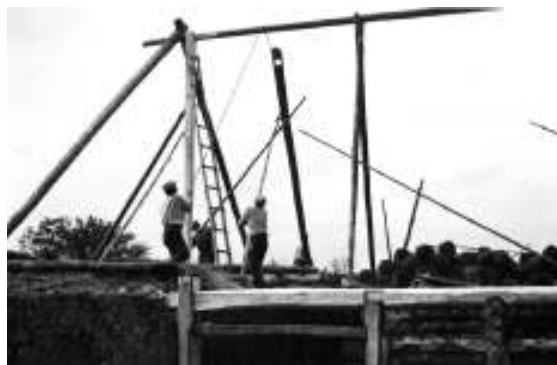
Pėdinės konstrukcijos stogo statyba, gegnės kabina ant permetės [5; 109]
