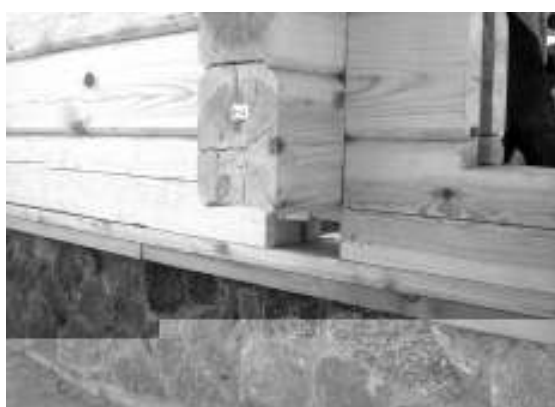
Juostinių pamatų arba gręžtinių pamatų rostverko išorinė siena gali būti apmūryta skaldytais lauko akmenimis. Papildomai hidroizoliacijai gali būti naudojamas maumedžio medienos apatinis sienojų vainikas arba 4–8 cm lentų paklotas [R. Bortkūno 2007 m. nuotr.]
