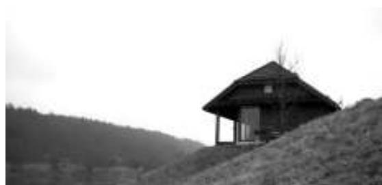
Plytų mūro vandens siurblinė sėkmingai rekonstruota: mūro sienų aukštis sužemintas, įrengta medinė perdanga ir nauja medinė pusvalminio stogo konstrukcija, lauko sienos apšiltintos ir apkaltos horizontaliomis rąstų aukščio dailylentėmis. Arch. N. Norvaišaitė, R. Bortkūnas, 2006 m.
