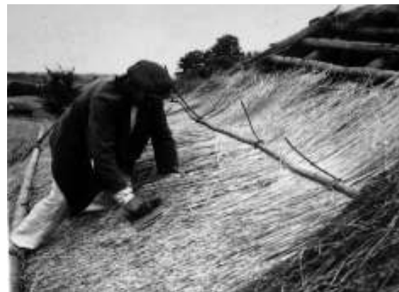
Gniūtelių priveržimas dengiant šiaudais stogą Drobiškio k. Linkmenų vls. Utenos aps. [ČDM, neg. 7929]
