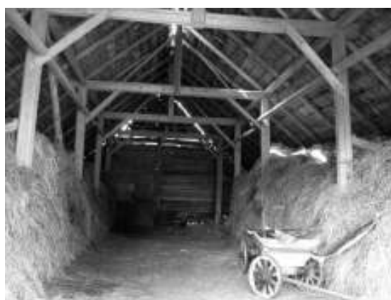
Kluono vidus: pėdinė konstrukcija Čigoniškių k. Zarasų r. [R. Bertašiūtės 2008 m. nuotr.]
