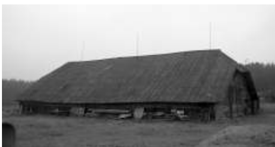
Rytų Aukštaitijai būdingas klojimų sienų ir stogų aukščių santykis. Aukštaitijos nacionalinis parkas. [R. Bortkūno 2007 m. nuotr.]
