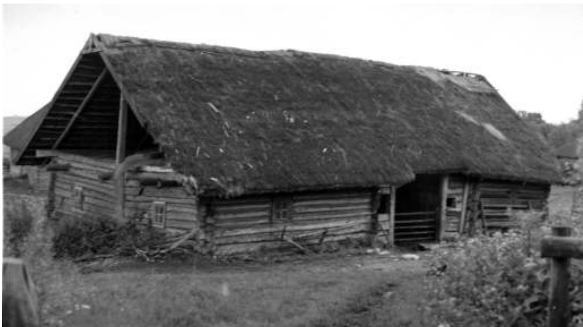
Tvartas su pedinės konstrukcijos stogu Antalamėstės k. Linkmenų vls. Utenos aps. [ČDM; neg. 4310]
